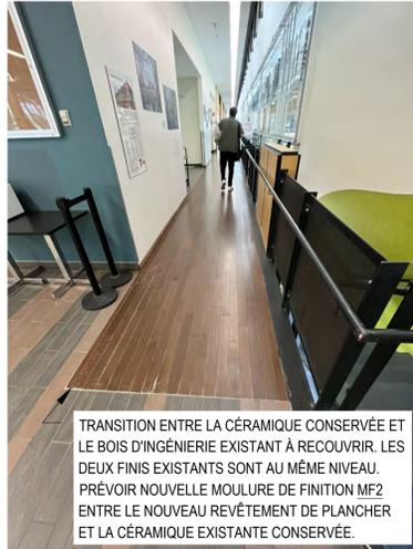
TRANSITION ENTRE LA CÉRAMIQUE CONSERVÉE ET LE BOIS D'INGÉNIEUR EXISTANT À RECOUVRIR. LES DEUX FINIS EXISTANTS SONT AU MÊME NIVEAU. PRÉVOIR NOUVELLE MOULURE DE FINITION MF2 ENTRE LE NOUVEAU REVÊTEMENT DE PLANCHER ET LA CÉRAMIQUE EXISTANTE CONSERVÉE.
