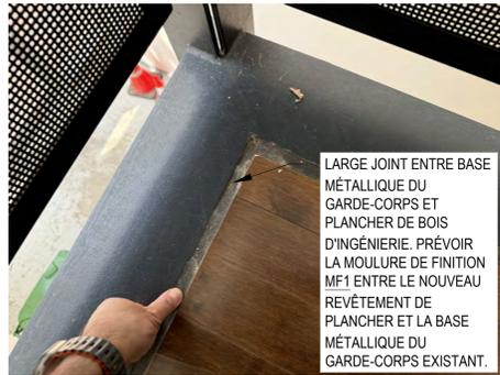
LARGE JOINT ENTRE BASE MÉTALLIQUE DU GARDE-CORPS ET PLANCHER DE BOIS D'INGÉNIEUR. PRÉVOIR LA MOULURE DE FINITION MF1 ENTRE LE NOUVEAU REVÊTEMENT DE PLANCHER ET LA BASE MÉTALLIQUE DU GARDE-CORPS EXISTANT.
