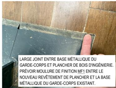
LARGE JOINT ENTRE BASE MÉTALLIQUE DU GARDE-CORPS ET PLANCHER DE BOIS D'INGÉNIEUR. PRÉVOIR MOULURE DE FINITION MF1 ENTRE LE NOUVEAU REVÊTEMENT DE PLANCHER ET LA BASE MÉTALLIQUE DU GARDE-CORPS EXISTANT.
