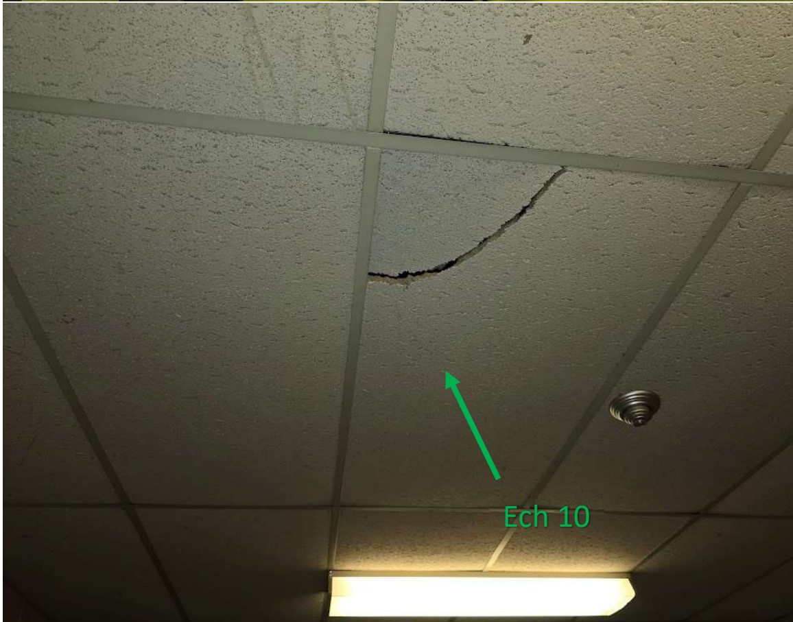
Photo 8 : Ech-10. Faux plafond, couloir, matériaux n'est pas considéré comme MCA.
