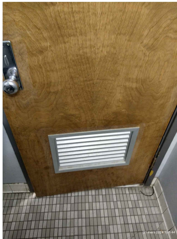
PHOTO PORTE TOILETTE
