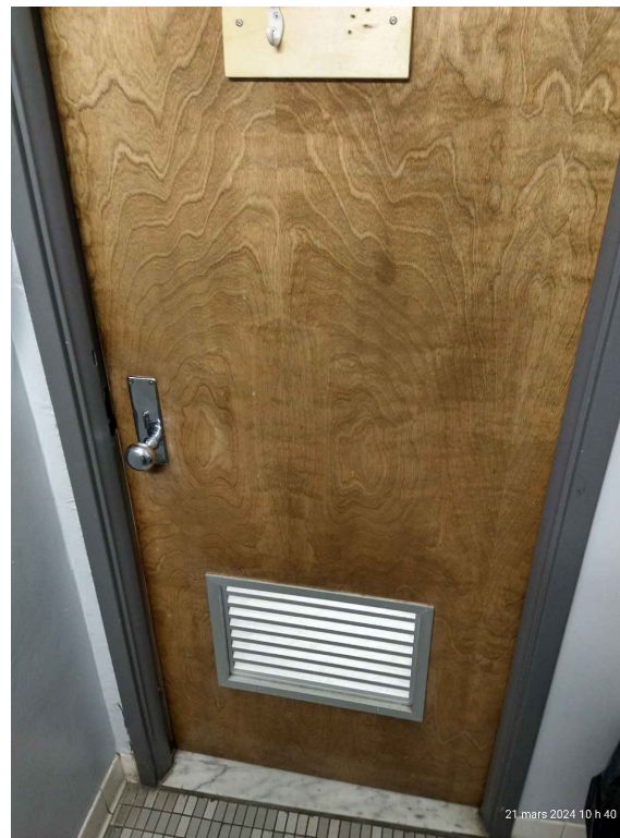
PHOTO PORTE TOILETTE
