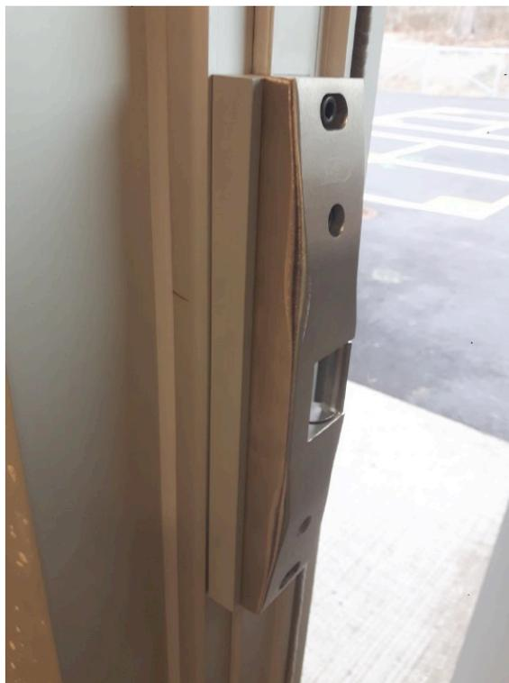
**Solutions d'installation acceptable pour fixer une gâche à un cadre en aluminium**
