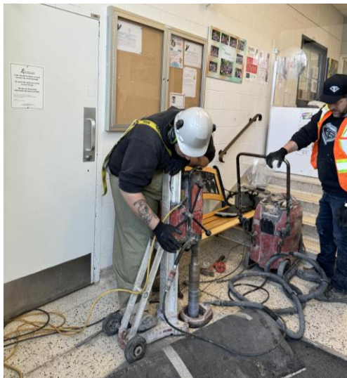
Photographie 1 : Réalisation du carottage F1
