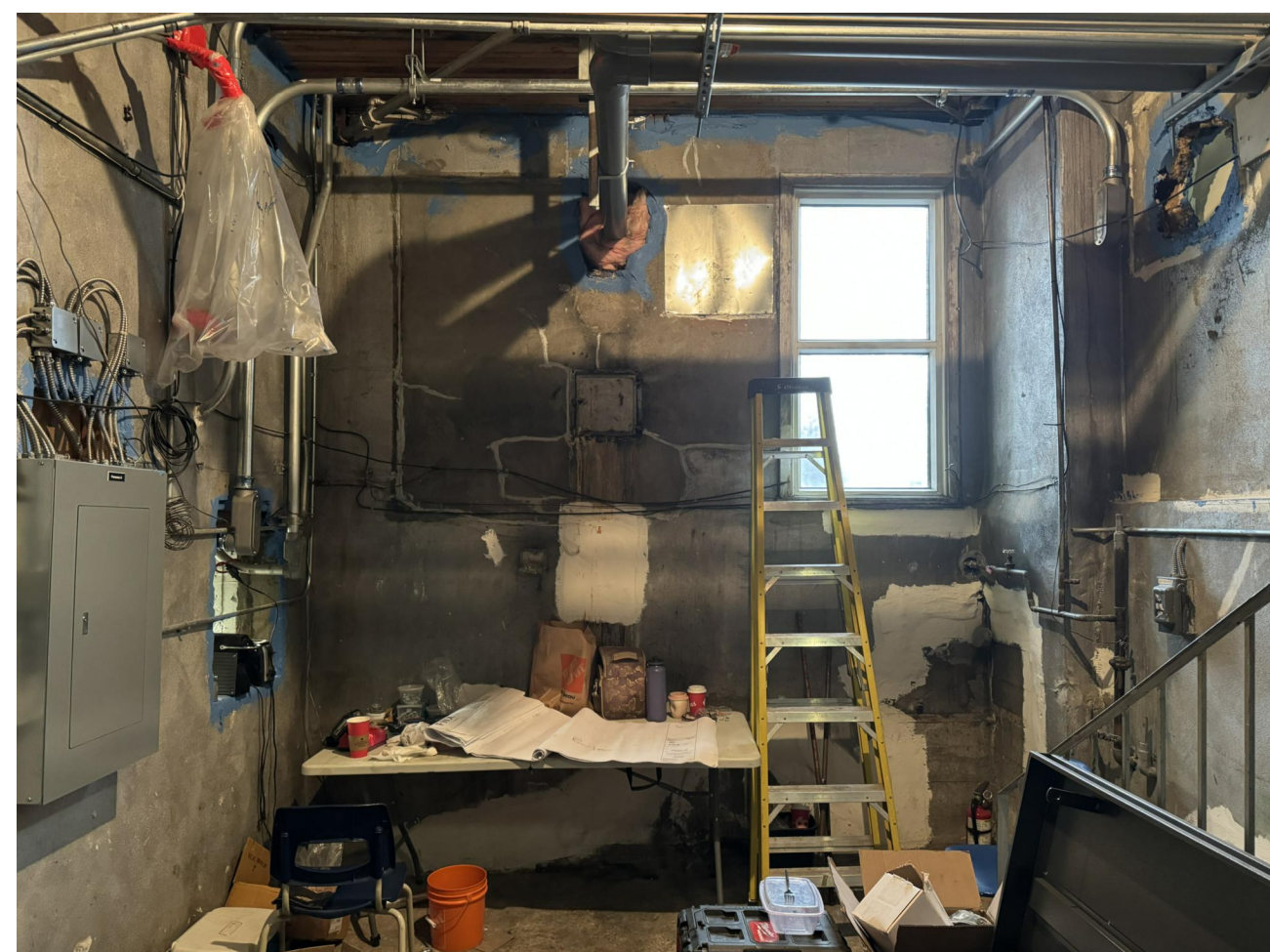
ESC.B - SOUS ESCALIER B
