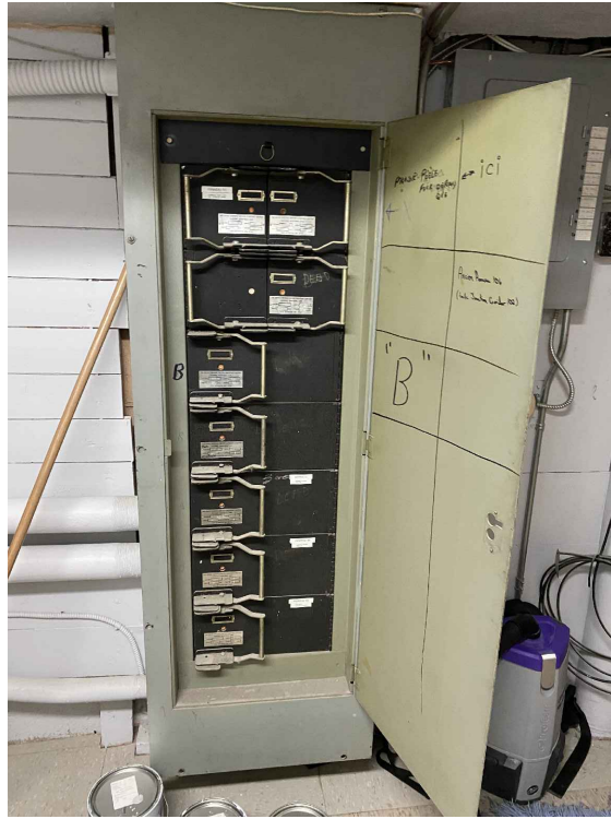
PANNEAU PRINCIPAL A SECTIONNEUR
