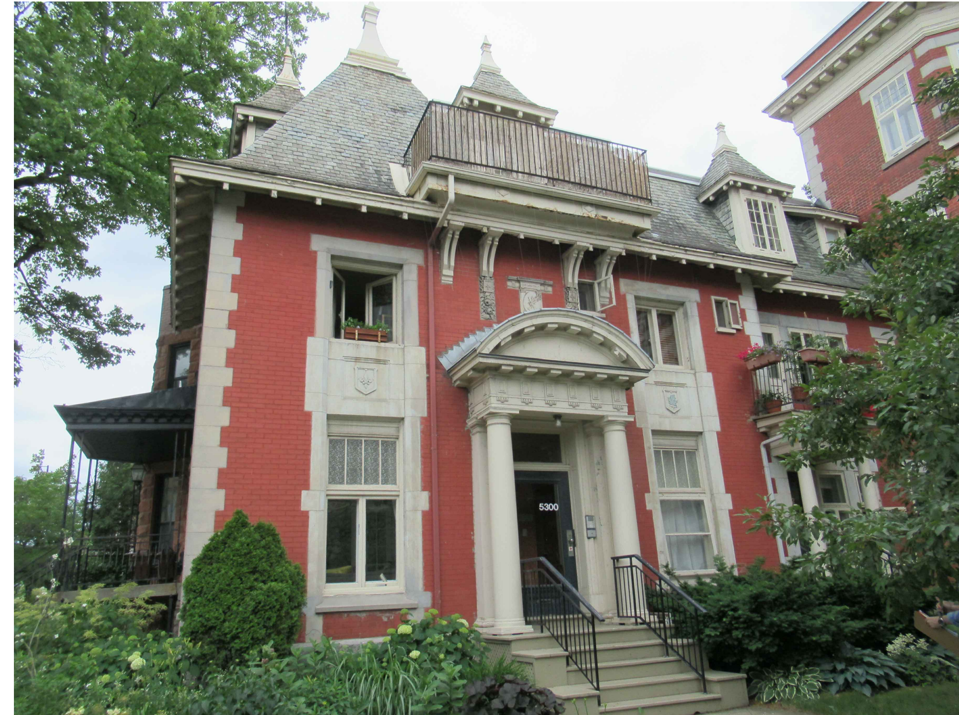
01 Façade avant - pavillon sud Aucune
