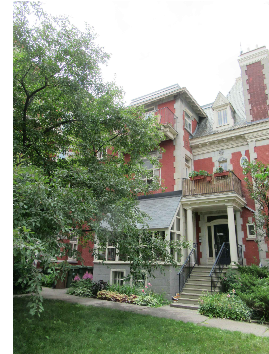
02 Façade avant - pavillon nord Aucune
